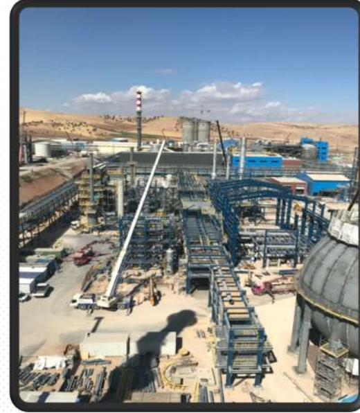
İNŞAAT, FABRİKASYON VE MONTAJ UYGULAMALARI
