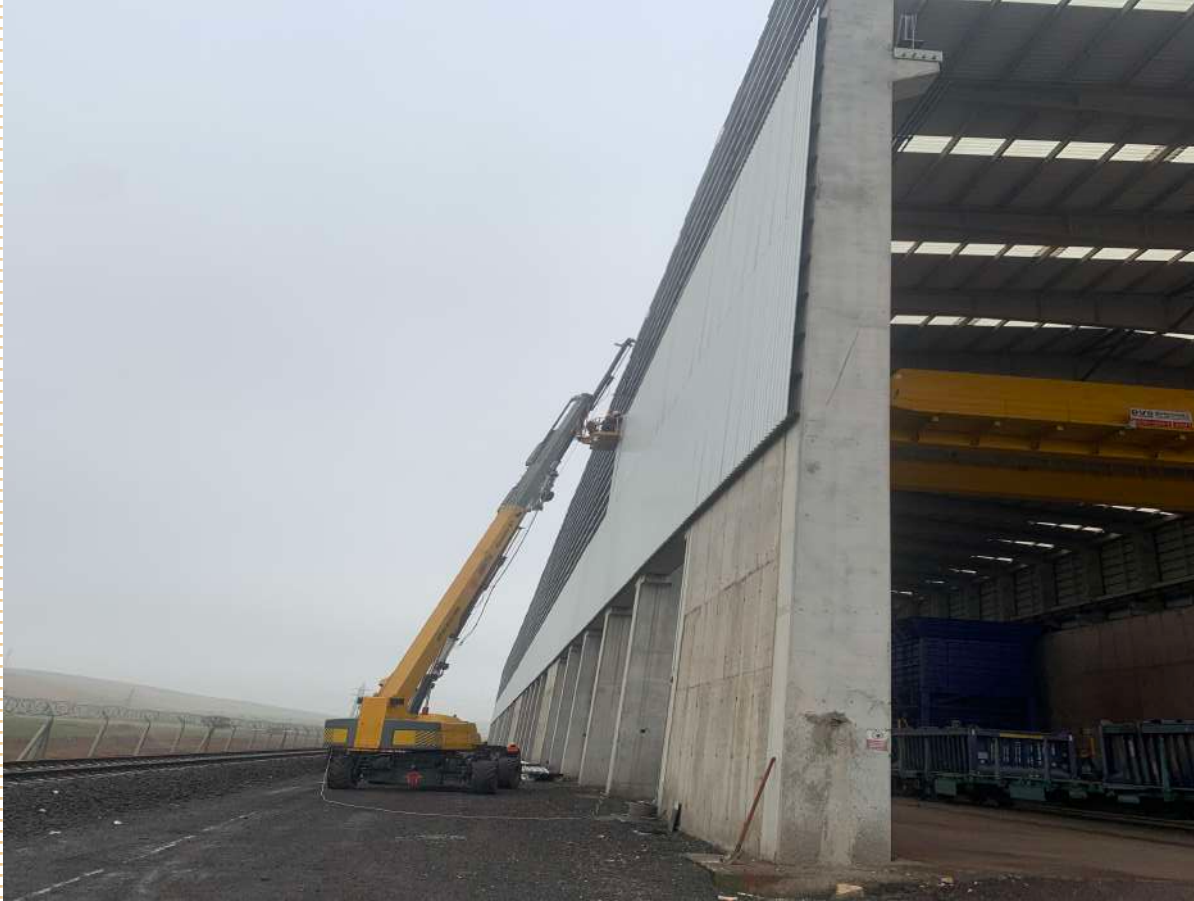
Etibakır Mazıdağı stokhol binası çelik ve cephe işleri
